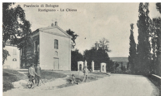
FIG. 4 La chiesa prima della costruzione della ferrovia Direttissima, che ora nasconde invece la facciata
