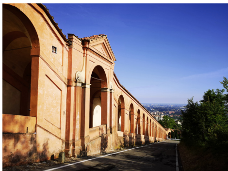
▲ Fig. 5. Bologna, Portico di San Luca, tratto collinare (fotografia dell'autore).
